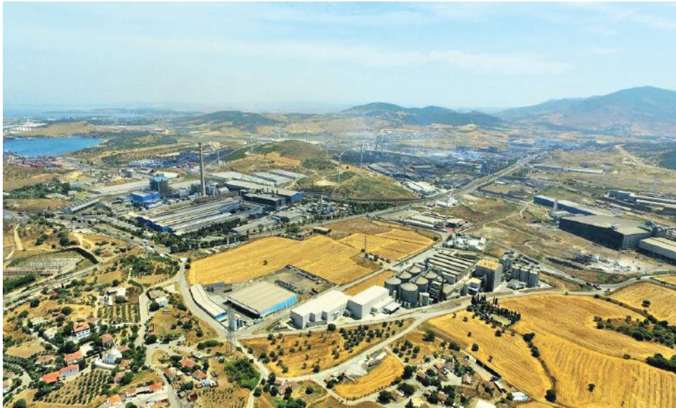
Foto 47. Aliağa ilçesindeki sanayi tesislerinin en yoğun olduğu Nemrut Sanayi Bölgesi'nden bir görünüm.
