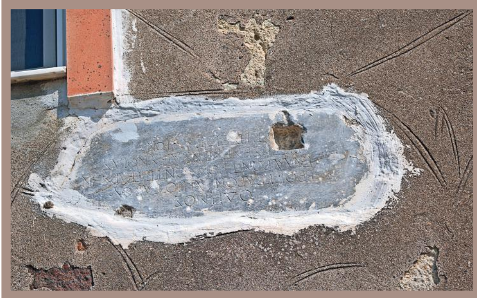
Res 8. Ali Ağa Cami dış cephe üzerinden bir görüntü
