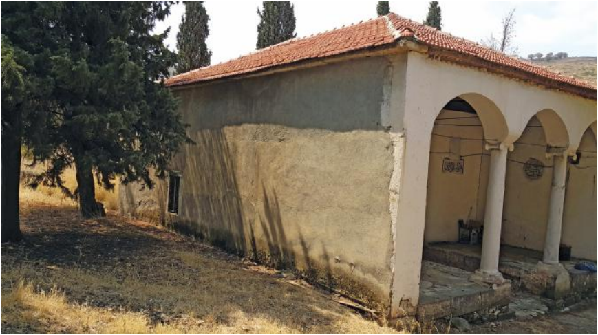
Fig. 4. Çaltılıdere Köyü Eski Cami doğu cephe.
