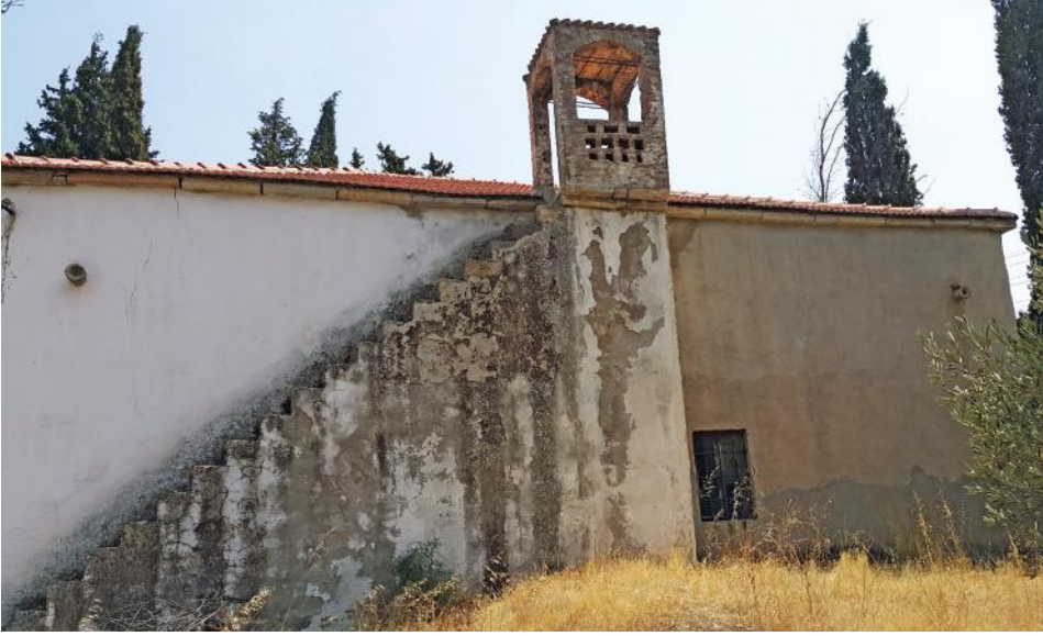
Fig. 6. Çaltılıdere Köyü Eski Cami batı cephe minare.
