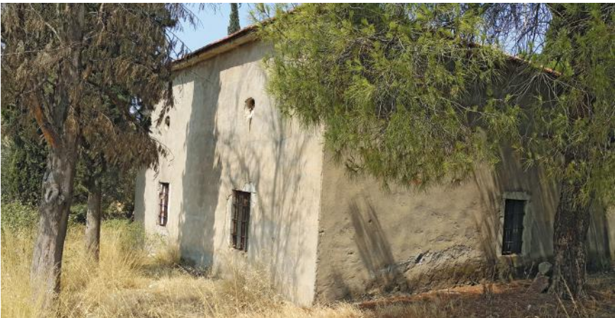
Fig. 5. Çaltılıdere Köyü Eski Cami güneydoğu cephe.
