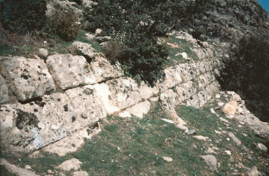
Fig. 9 Melanpagos Eğimli Duvar.
