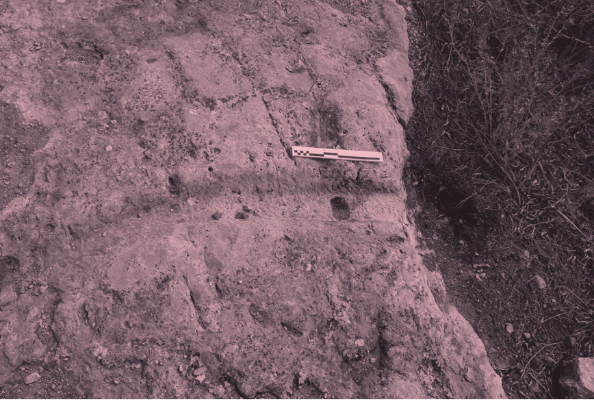
Fig. 13 Ana kayadan blok taş çıkarılmasıyla ilgili taşçı izleri.
